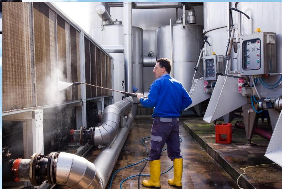
Pulizia batterie di raffreddamento
