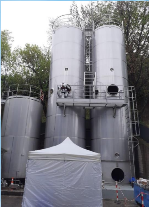
Ispezione del cantiere
