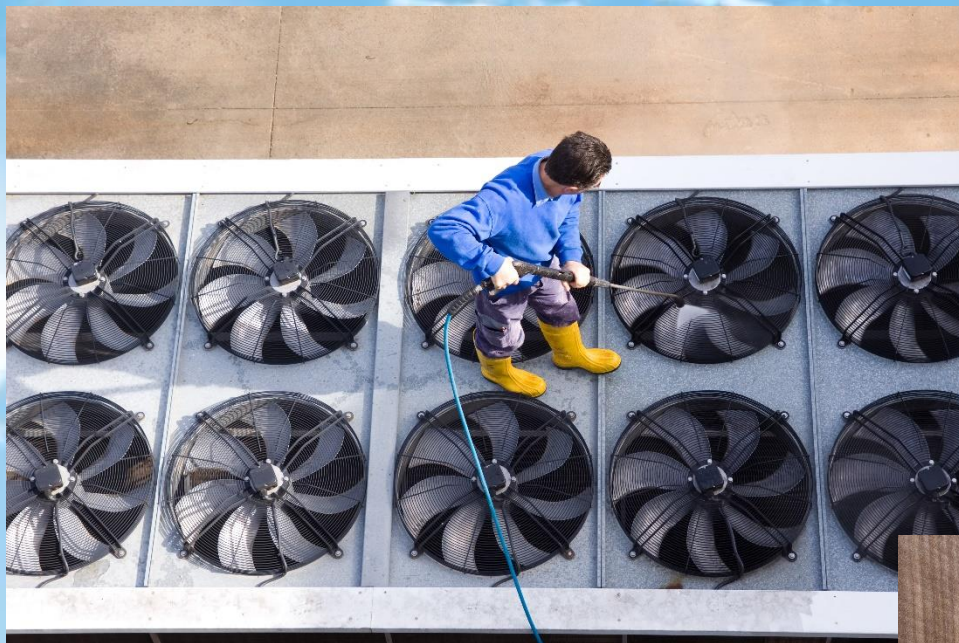
Pulizia batterie di raffreddamento
